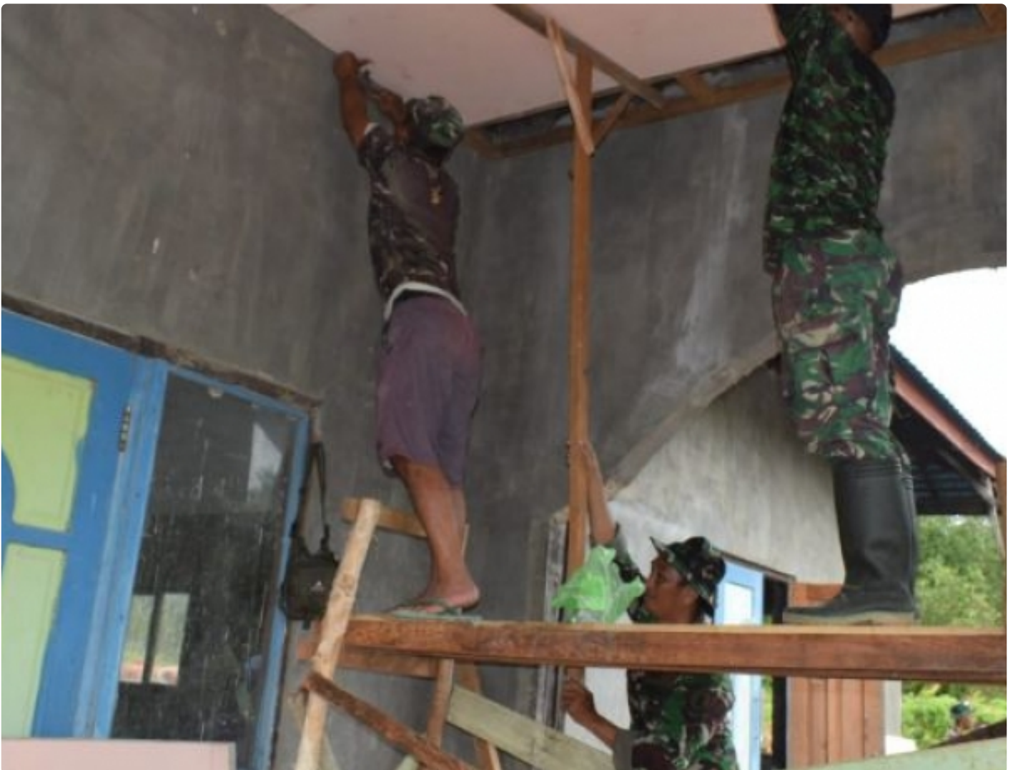
Anggota Satgas tMMD Pasang Plafon Masjid
